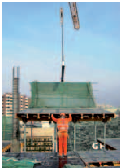
Elevación y colocación de mesa con barandillas incorporadas
