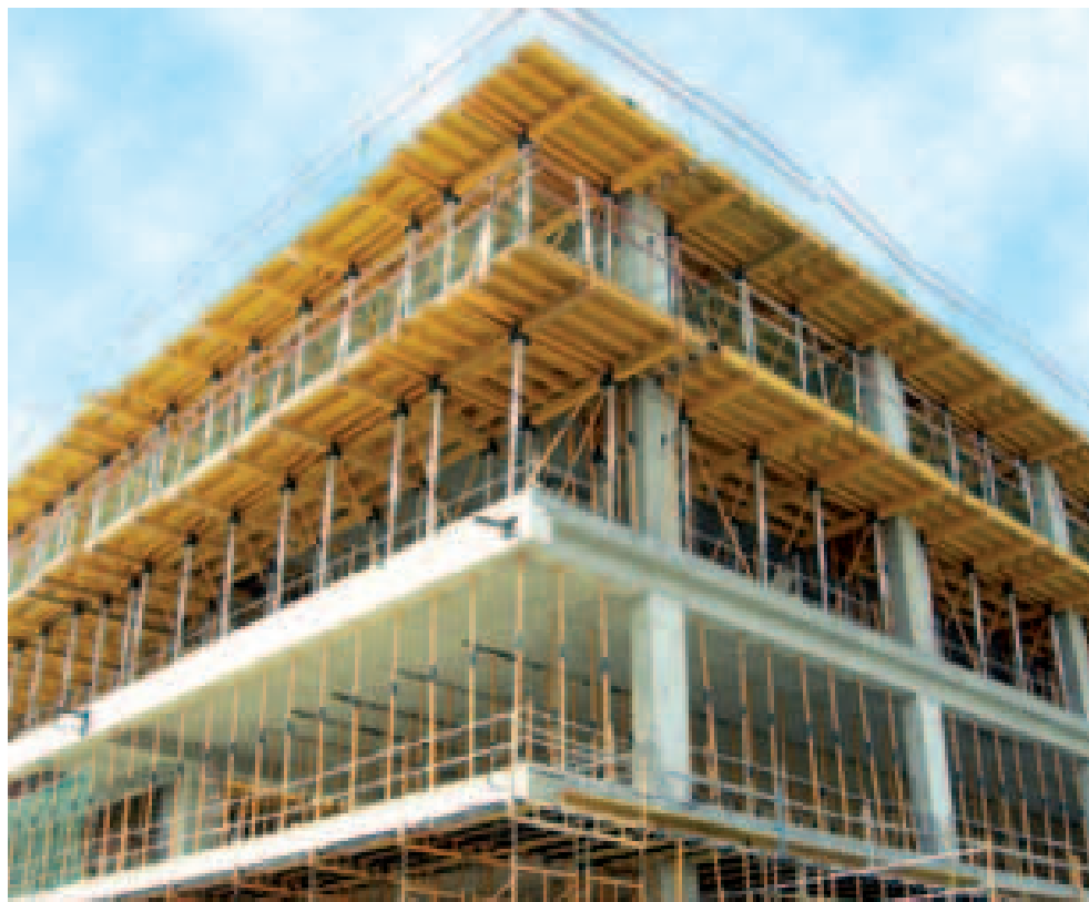
Solución de encofrado perimetral con Mesas VR
