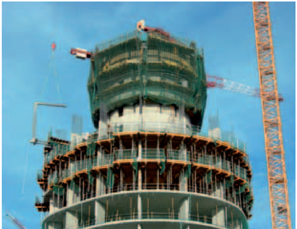
Ejecución de losas con mesas trapezoidales en las Torres FIRA de Barcelona, España
